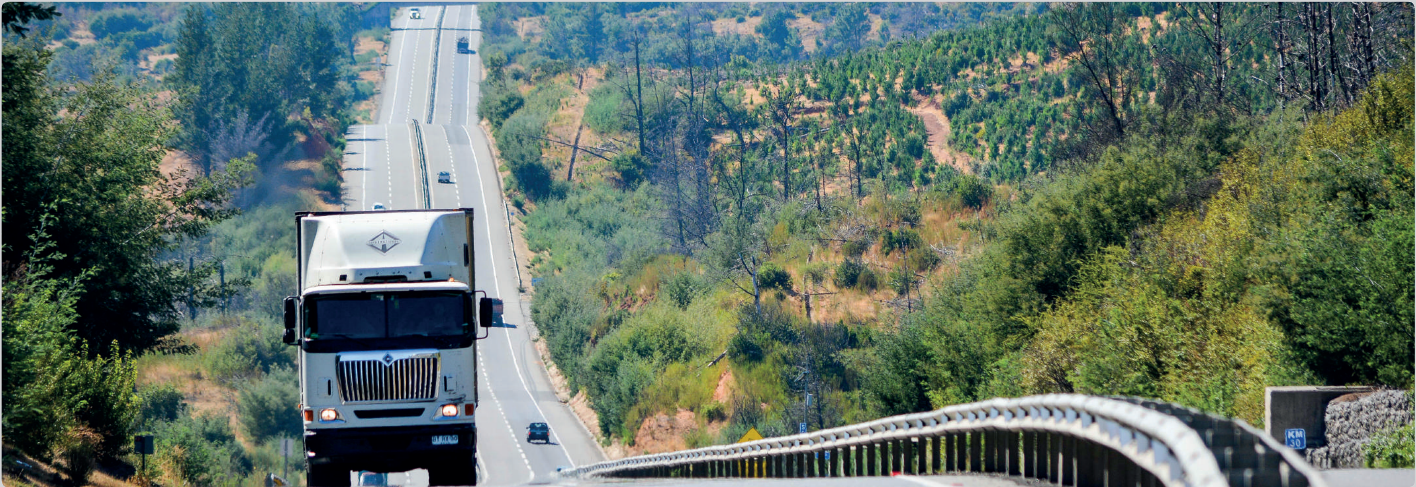
Autopista del Itata, sector Aguas Abajo / Autopista del Itata Aguas Abajo area
