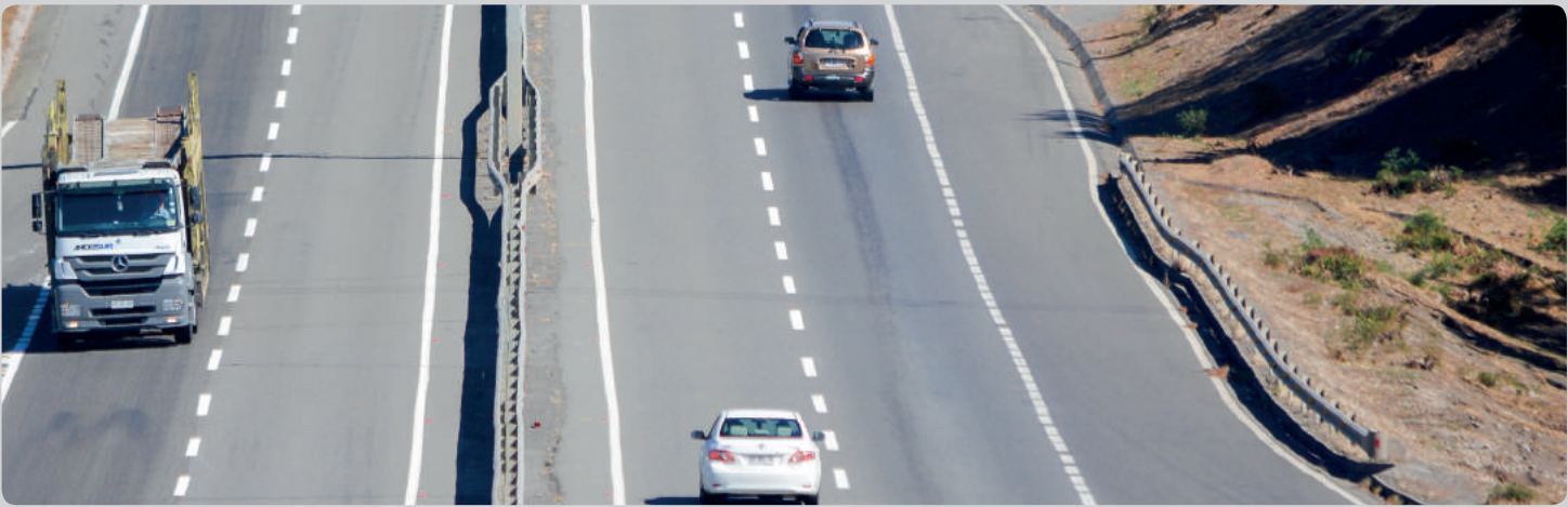
Sector conexión Ruta 5 Sur / Junction Area - Ruta 5 Sur.
